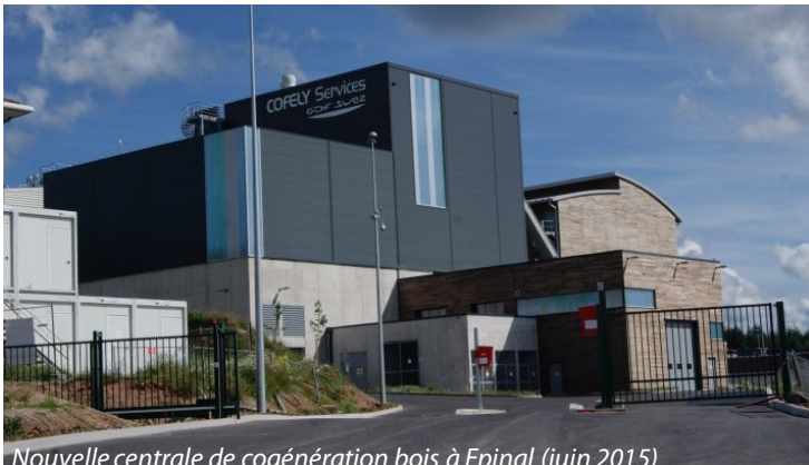
Nouvelle centrale de coaénération bois à Epinal (juin 2015)
