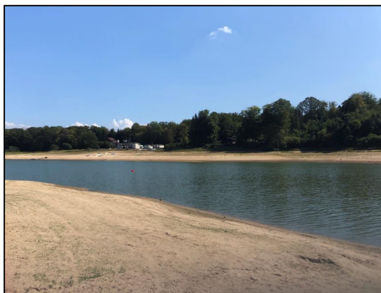
Figure 42 : Photographie du Réservoir de Bouzey asséché en date d'août 2019 – Source : SCoT des Vosges Centrales
