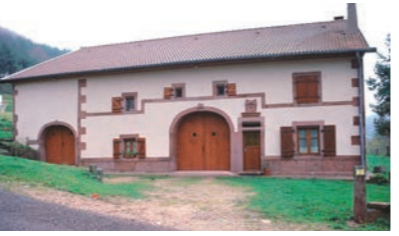
Soubassement, bandeaux, encadrements et chaînages d'angle en grès rose Pays de Remiremont
