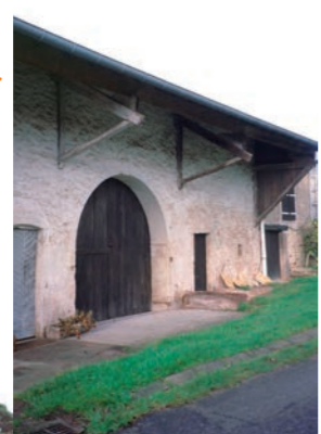
Volume complexe d'une ferme sur cour Vosges saônoises
