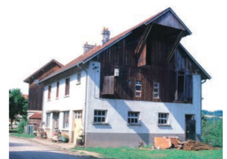
Ferme de la Reconstruction pourvue d'une gerbière en pignon Montagne Nord
