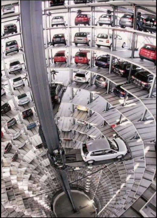
Parking silo automatique. Wolfsburg (VW)
