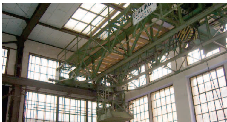
Intérieur d'un des bâtiments
