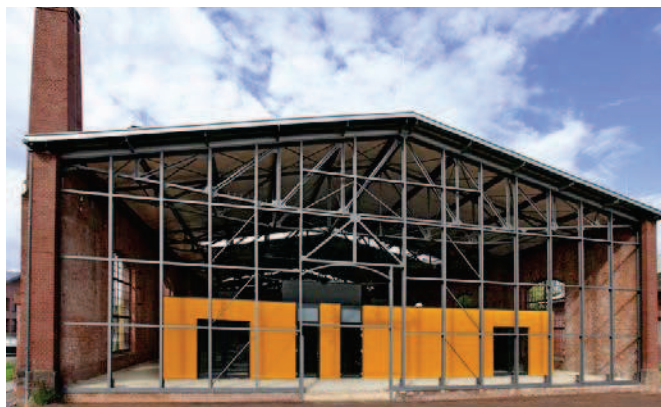
Les anciens ateliers ferroviaires
