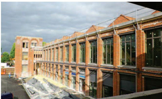
L'ancienne filature en pleine rénovation
