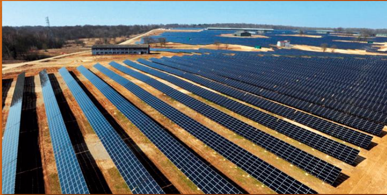
Centrale PV de Toul - Rosières
