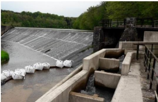
*Exemple de Barrage hydroélectrique compatible avec les objectifs réglementaires à La-Vôge-les-Bains avec clapet sédimentaire et passe à poissons*
