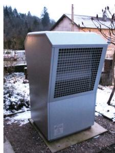
Dite pompe à chaleur air/eau, un moteur électrique diffuse à l'intérieur de la maison, par circulation d'eau chaude, les calories de l'air extérieur. Son coefficient de performance (COP) réel est autour de 2, c'est à dire que pour 1 kWh d'électricité consommé, 2 kWh de chaleur sont produits.
