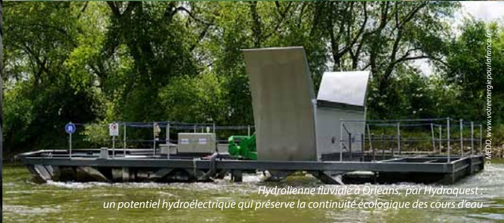
Hydrolienne fluviale à Orléans, par Hydroquest : un potentiel hydroélectrique qui préserve la continuité-écologique des cours d'eau
