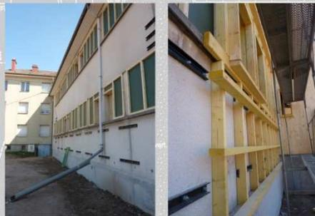
Une double structure en ossature bois est réalisée sur la totalité du bâtiment existant afin d'y disposer deux couches de 145 mm d'isolation.
